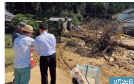
台風15号被害視察(神増地区)
